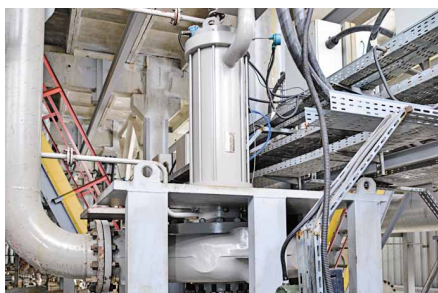
Герметичный насос крупным планом
