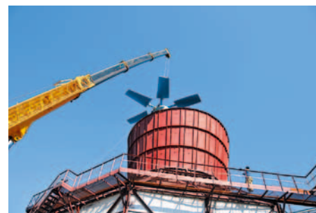
«Примерка» вентагрегата
