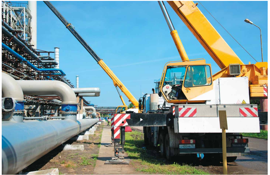
Грузовой автокран FAUN на площадке завода «Омский каучук»
